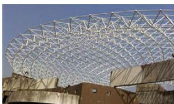
Gambar 31. Struktur *Space Frame*
