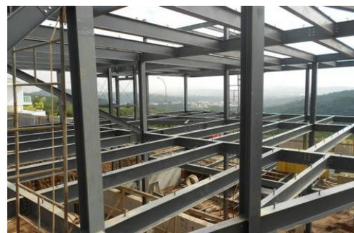
Gambar 27. Struktur Rangka kaku
