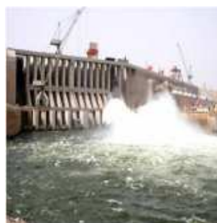
a) Merowe Dam
